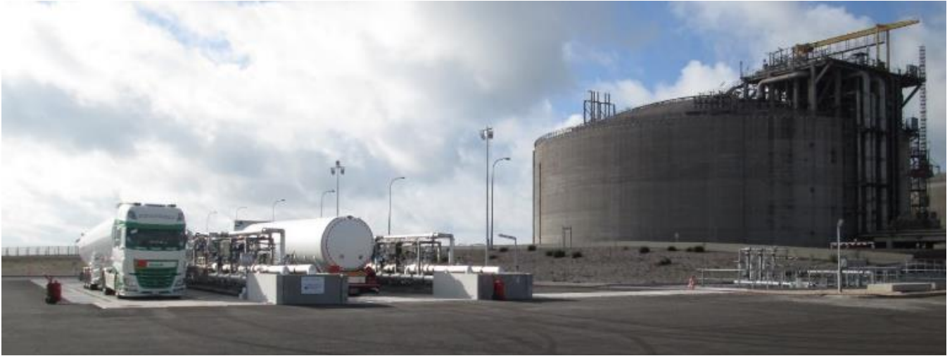
Terminal méthanier Elengy de Fos Cavaou – station de chargement de camions citernes en GNL ©photo Elengy
